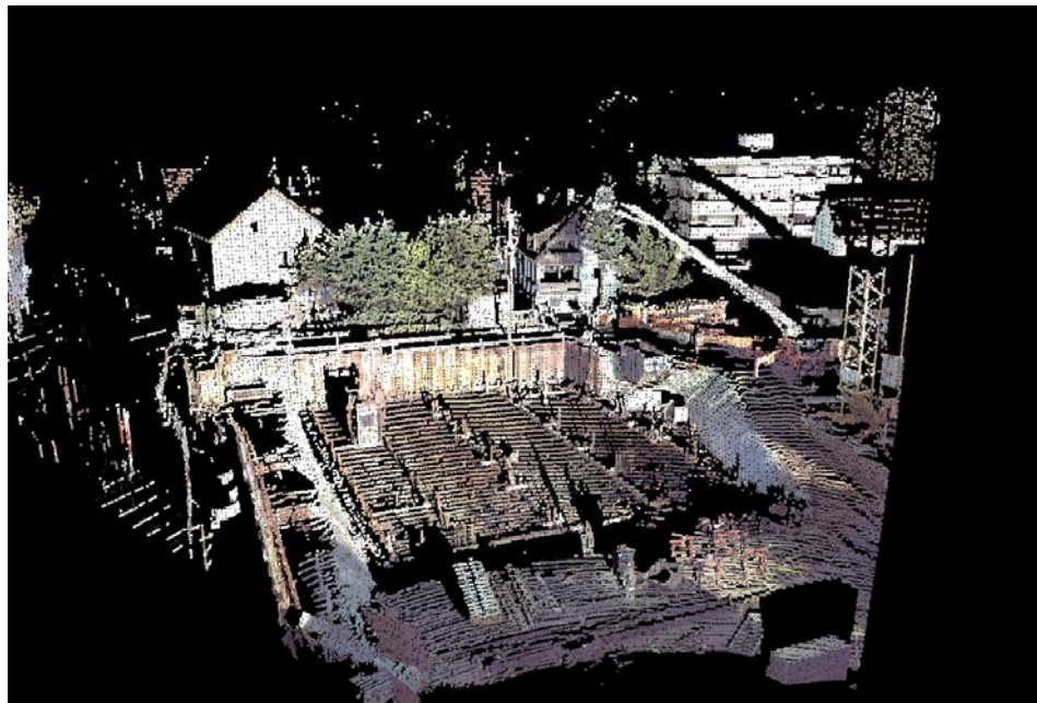
Abb. 4: Punktwolke (point-cloud) der gescannten Baugrube
