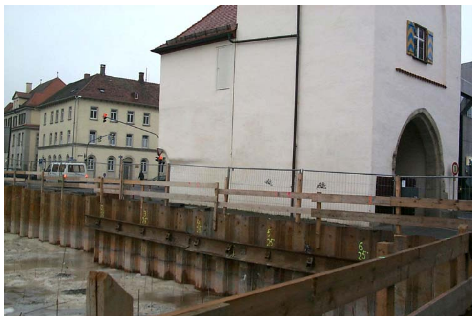
Abb. 7: In unmittelbarer Nähe zum Ulmer Tor durchgeführte Baumaßnahme (2002)
