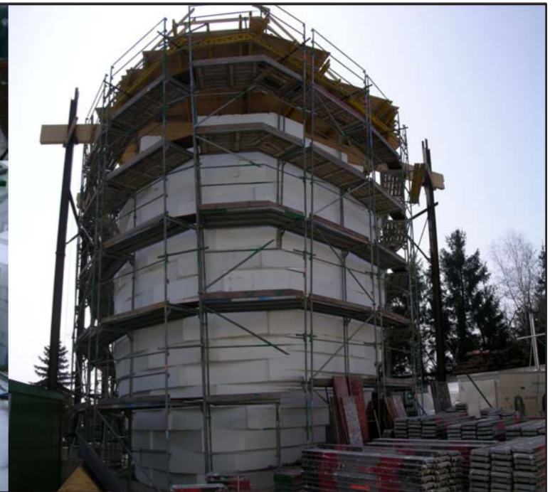
Abb. 2a: Bauphase (Negativ-Modell) 2b: Außenansicht des fertig gestellten IGLU-Baltringen
