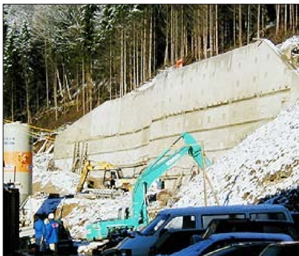
Abb. 5b: Ausführung einer rückverankerten Stützmauer
