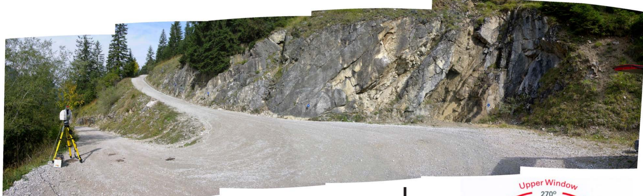
Abb. 2a: Umfassende und sichere Aufnahme einer Felsböschung mit 3D-Laserscanner
