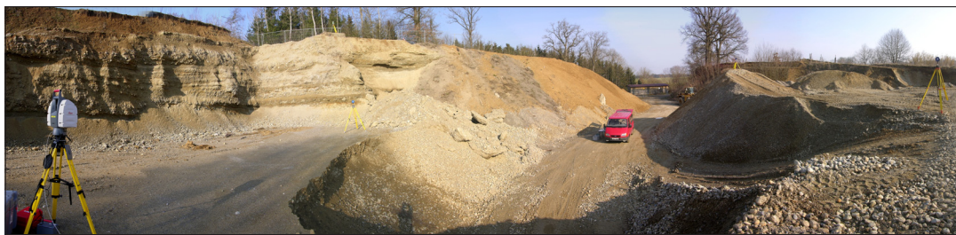
Abb. 1: Kiesgrube (Stand 2007) mit Laserscanner LEICA HDS-3000
