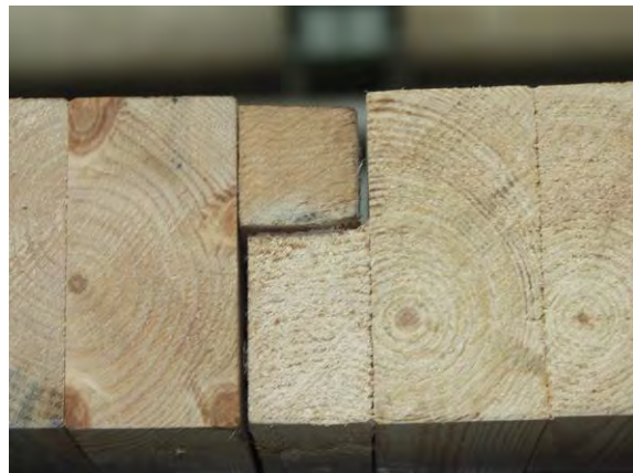
Abbildung 6-11 Stoßausbildung zwischen den beiden Deckenelementen der Brettstapeldecke
