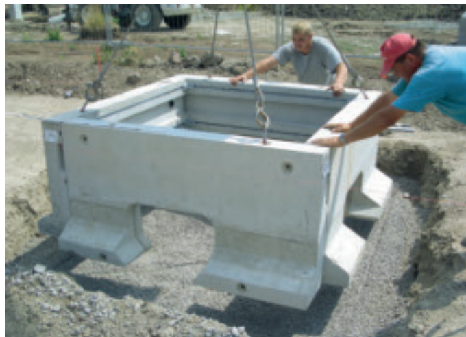
Aus Fertigteilen zusammengesetztes Baumquartier im Gewerbegebiet.
