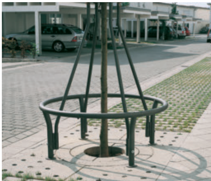
Eine Radlast von 5 t halten diese Abdeckscheiben aus.
