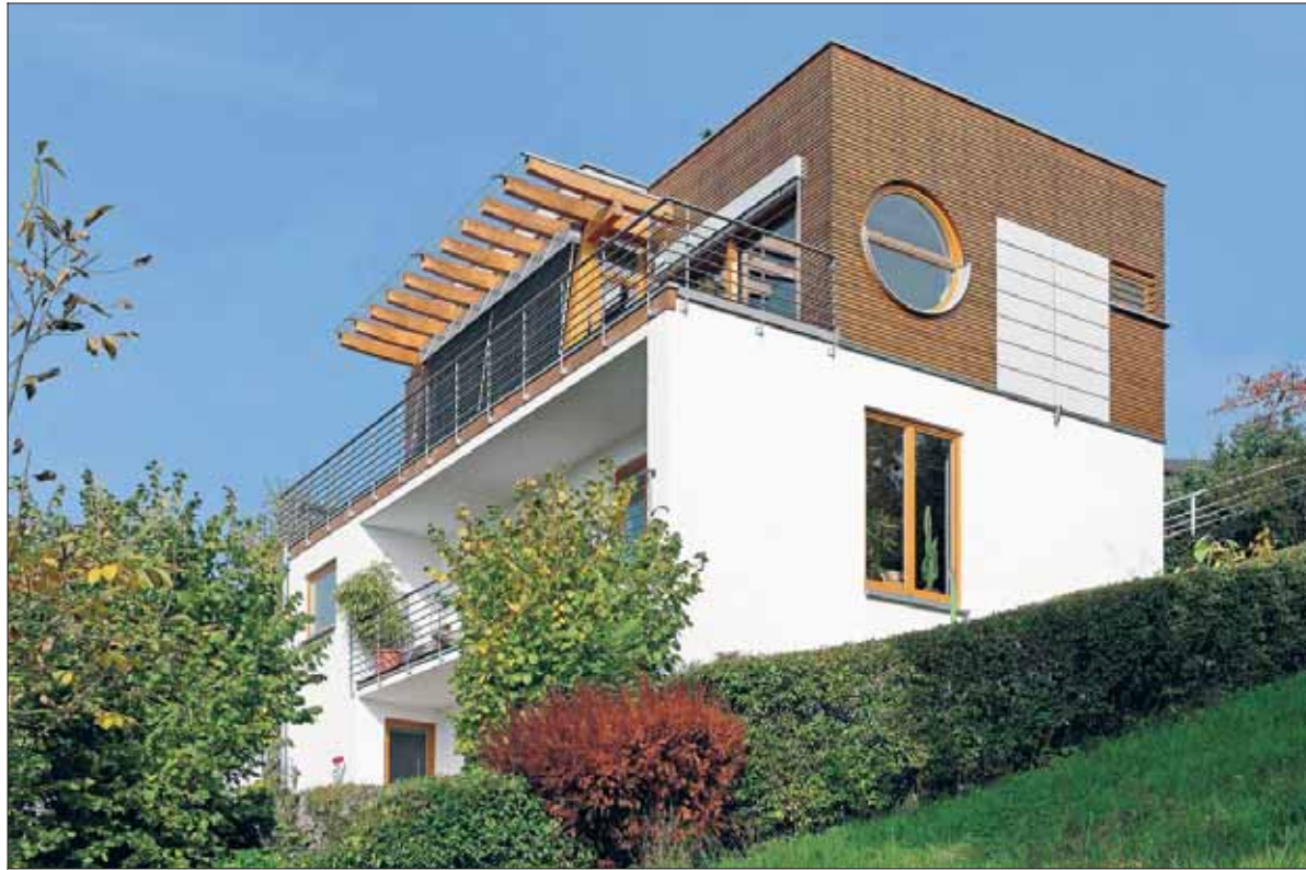
Die Dachaufstockung in leichter Holzständerkonstruktion verleiht dem zu klein gewordenen Einfamilienhaus eine neue, moderne Form.
