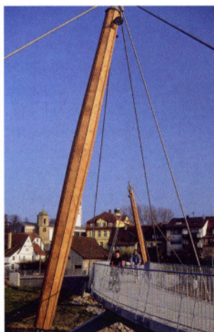
Abb. 17: Neckar-Brücke, Wernau D, 1990. Die Abdeckung der Pylone er- folgt mit durchgehenden Strei- fen aus Furnierschichtholz Kerto über einer dampffoffenen Pappe. Sie sind als austausch- bare Verschleißteile geplant.
