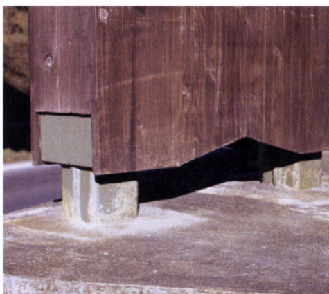
Abb. 20: Stützenfuß auf Betonsockel, eingelassene Stahlbleche mit Tropfkante
