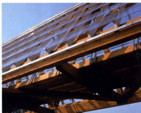
Abb. 12: Schuppenförmige Verlegung der 10 mm dicken Sicherheits- glasscheiben, Abstand 100 mm
