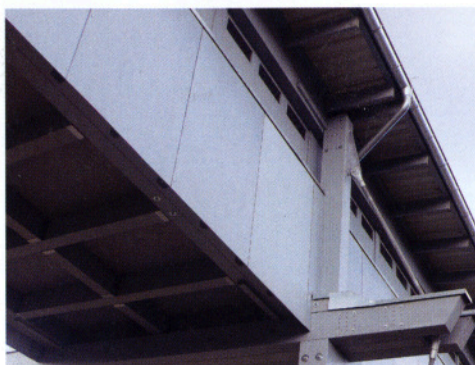
Abb. 10: Flughafen Tegel, Berlin D. Überdachte Trogbrücke mit kompletter seitlicher Beklei- dung aus Holzwerkstoff-Plat- ten.
