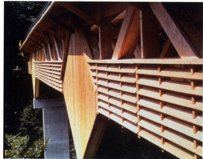
Abb. 1: Simme-Brücke, Wimmis CH, 1989. Der seitliche Überstand des Daches von 1,50 m und die jalousieartige Anordnung der Brüstungsbretter aus Lärche verhindern das Eindringen von Niederschlag in die unteren Tragwerksteile.
