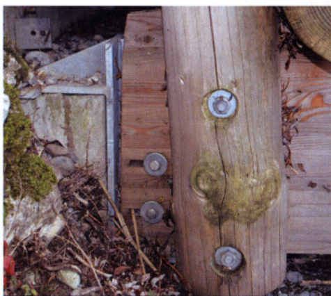
Abb. 21: ungeschütztes Hirnholz, Was- ser kann direkt zwischen Stahl- platte und Hirn- holz eindringen.
