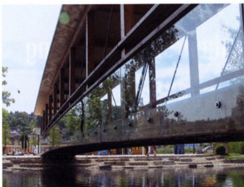
Abb. 9: Brenzhausbrücke, Heidenheim D 2006, Verglaste Brüstungs- elemente bieten den erforderli- chen Schutz der Untergurt- knoten
