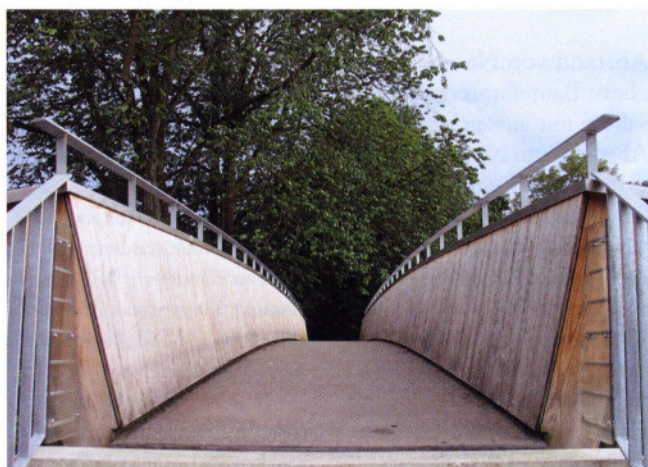
Abb. 15: Passerelle Hünenberg CH, 2004 Innenbekleidung: Dreischicht- platten Douglasie hinterlüftet, Außenbekleidung: Rauten- schalung Douglasie, oben: Brüstungsblech
