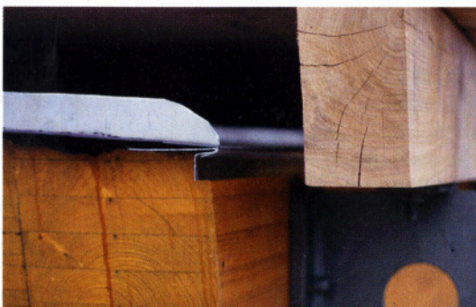
Abb. 6: Blechabdeckung von Haupt- und Nebenträgern
